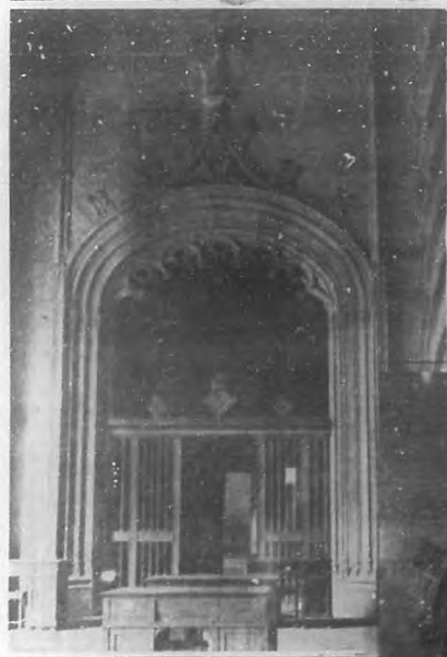
Entrada a la Capilla. (Fotos C. Barthon C.)
