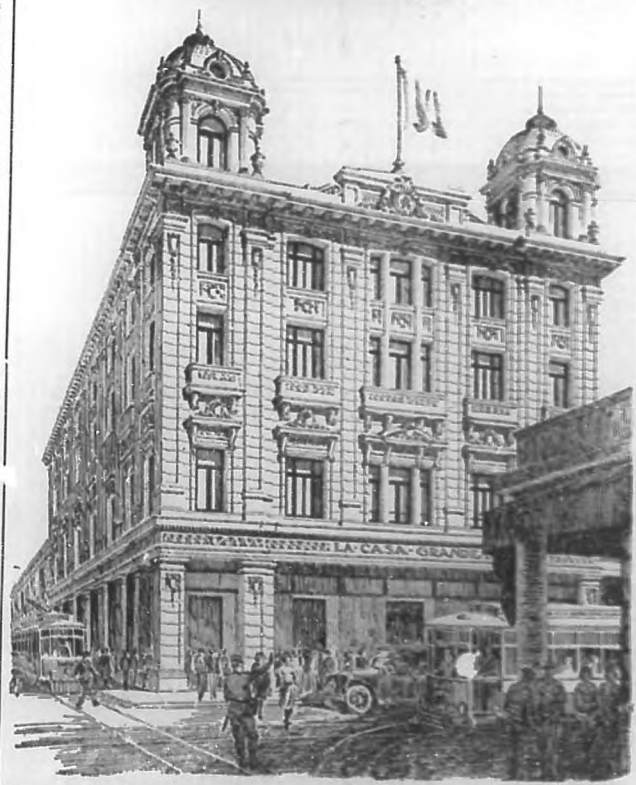
Proyecto del Edificio que para la "Casa Grande" construyen los ingenieros Albarrán y Bibal. Una joya arquitectónica, en la que se emplea el Cemento Cubano EL MORRO
